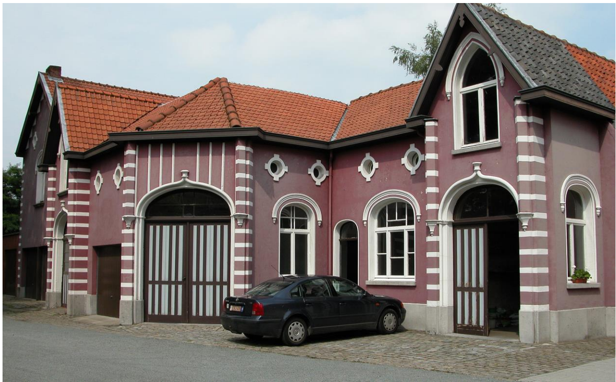
Het zogenaamde paviljoen, wellicht eertijds koetshuis van de woning d'Arippe.
